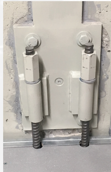
Ankerplatte mit Dywidag-Stangen
