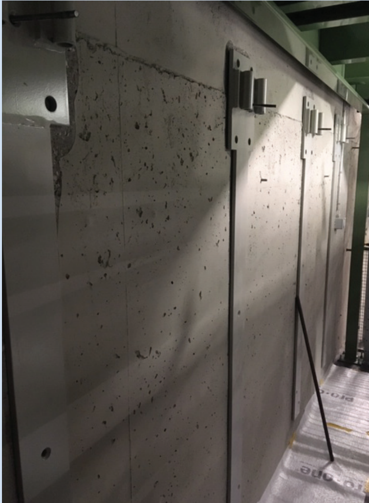
Stahl-Lamellen mit Ankerplatte
