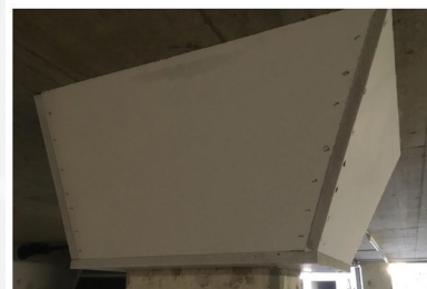
Anbringen von Brandschutz
