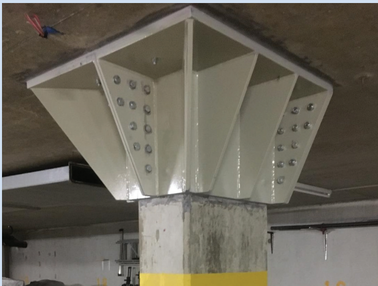
Stützenkopfverstärkung StüKo fertig montiert
