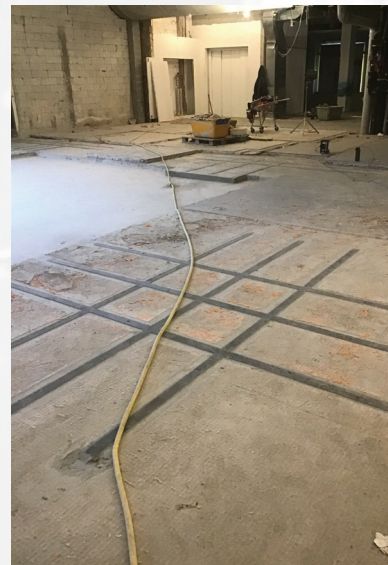
Lamellen kreuzweise eingebaut
