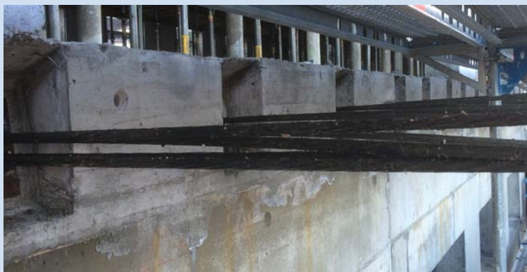
eingebaute Kabelbündel vor Spannarbeiten
