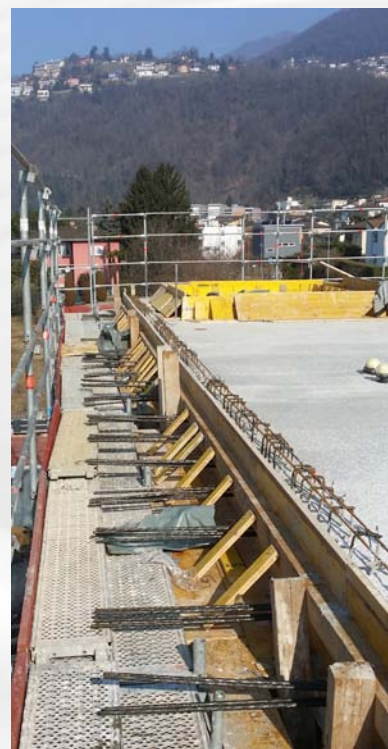
eingebaute Kabelbündel vor Spannarbeiten
