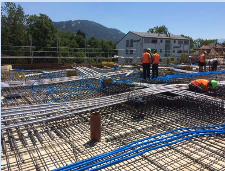
Decke über Erdgeschoss mit Spanngliedern
