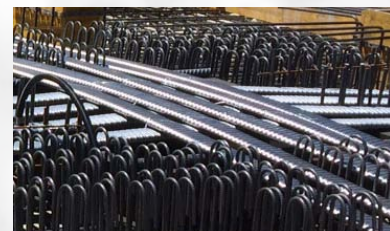
kreuzweise geführte Spannglieder
