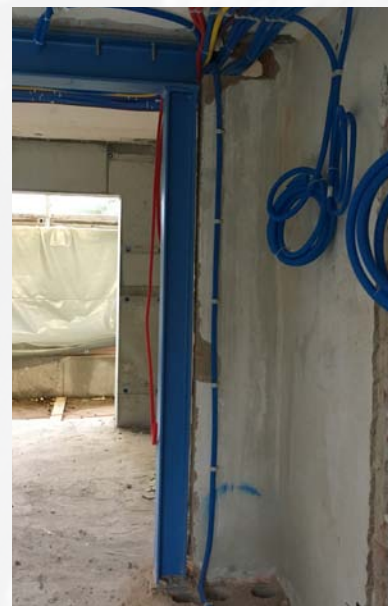
Stahlstütze und Verbundträger
