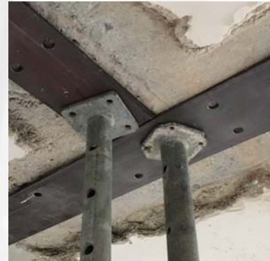
Montage der Bohrschablonen
