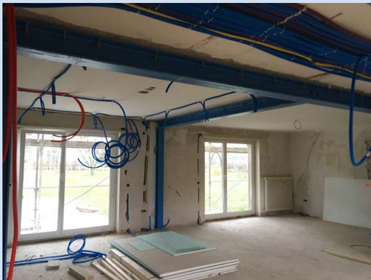
Fertig montierte Verbundträger
