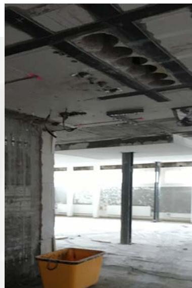
CFK-Lamellen um Bohrungen
