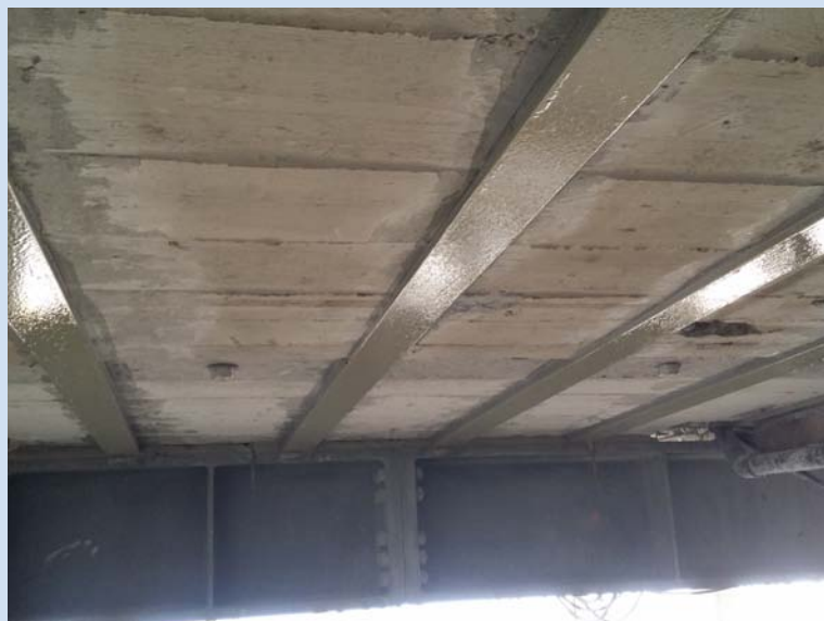
Lamellen unter Decke
