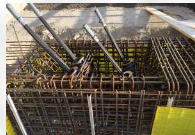
Spannverankerung mit Armierung
