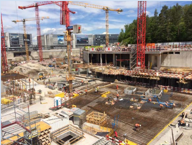
Übersicht Bodenplatte 1. Teil
