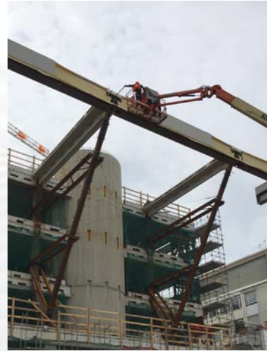
Einstossen von Vorspannlitzen
