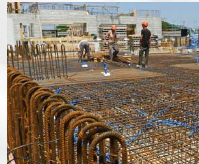
Deckenschalung mit Armierung
