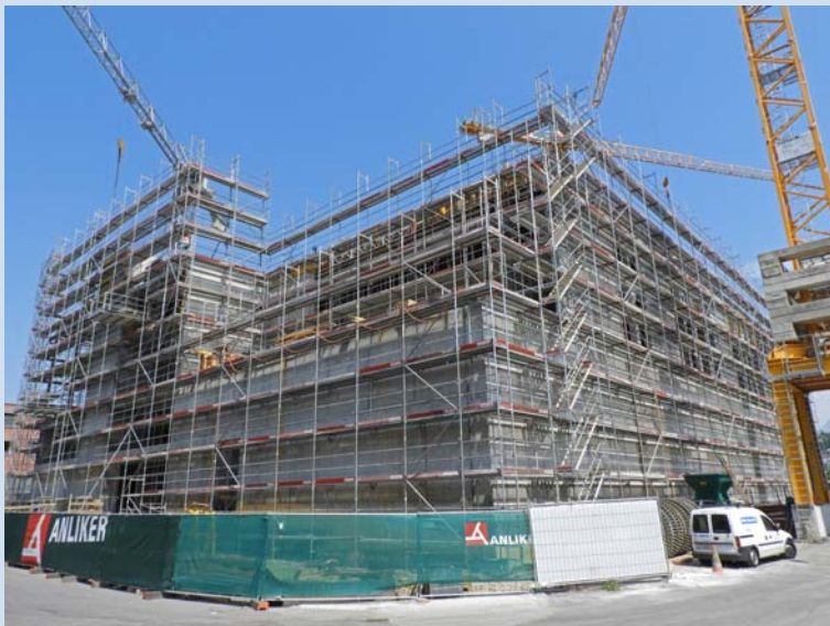
Gebäudeansicht während der Bauphase
