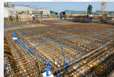
Deckenschalung mit Armierung
