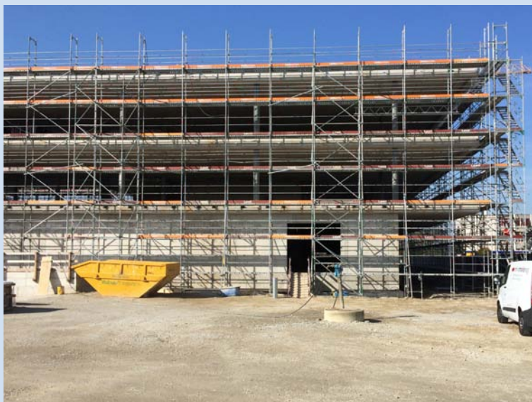
Rohbau von aussen
