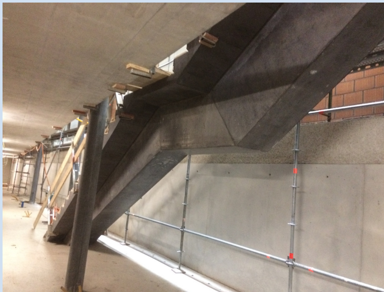
Untersicht der Treppe
