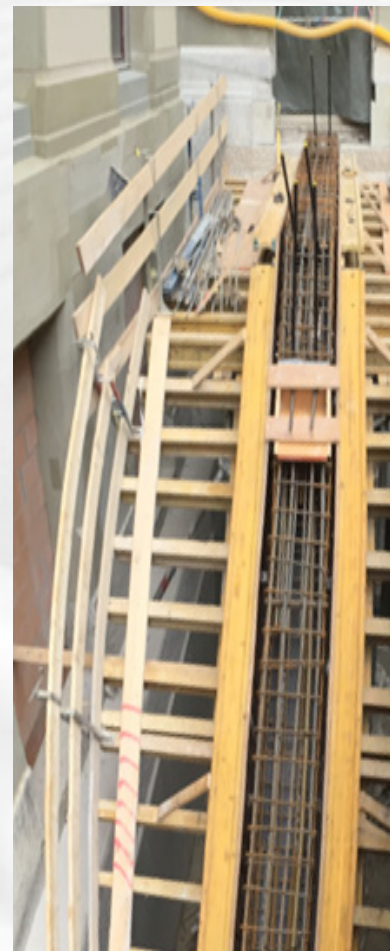
Schalung des vorgespannten Trägers
