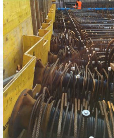
Spannverankerung CONA CMI
