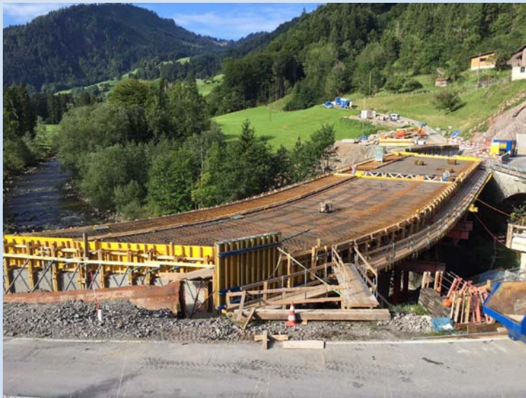
Armierte Brücke vor dem Betonieren
