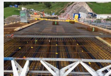
Vorspannkabel in Brückenplatte
