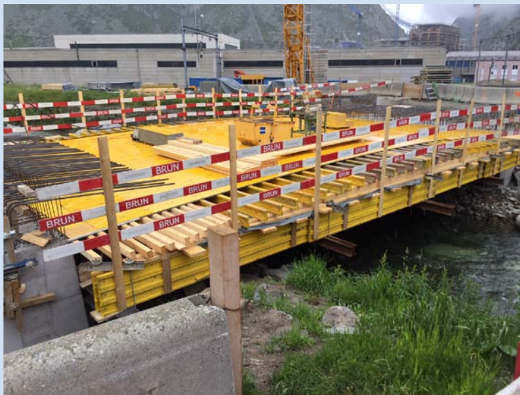
Ansicht Brücke Bauzustand
