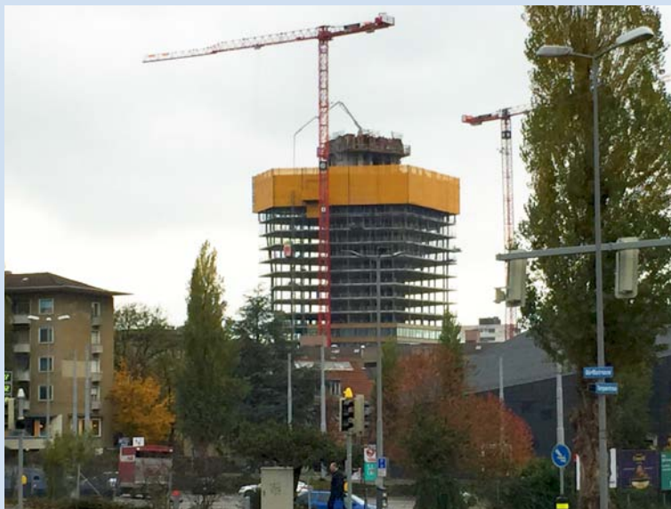
Ansicht im Bauzustand November 2017
