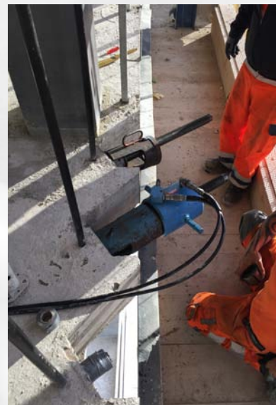
angesetzte Spannpressen
