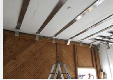
Lamellen vor Aufbringen der Vorspannung
