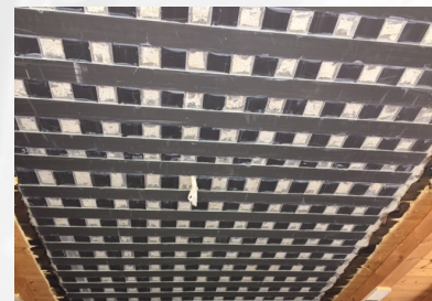
Lamellen quer und längs verlegt
