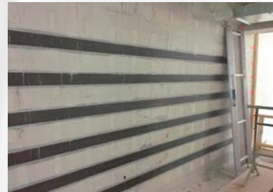
verstärkte Wand mit CFK-Lamellen
