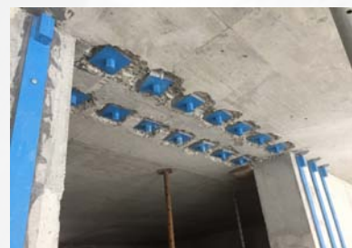
Decke über EG mit Wanddurchbruch
