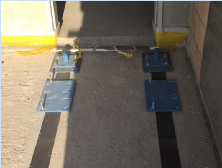
Einbausituation CFK-Lamellen
