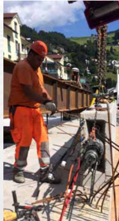
Gerschnibrücke: Vorspannen einer Brüstung
