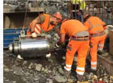
Spannarbeiten mit der Presse
