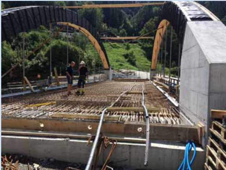
Ziegelbrücke: Brückenplatte mit Vorspannkabeln
