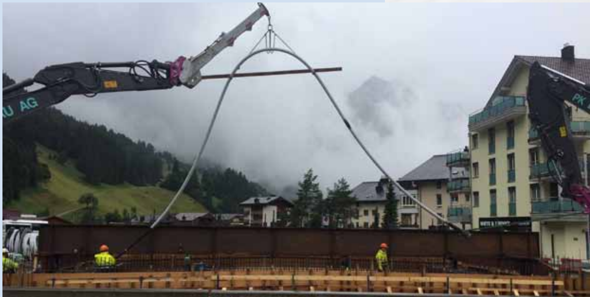
Gerschnibrücke: Verlegen eines Vorspannkabels
