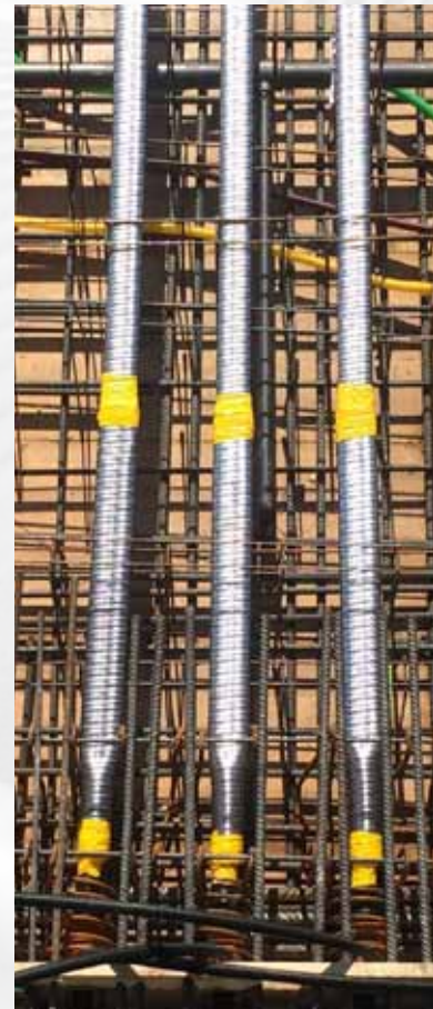
Decke mit Verankerungen
