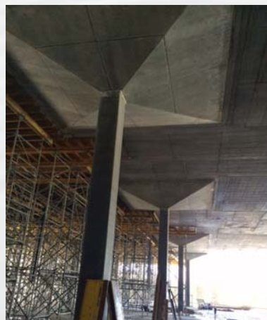
Untersicht der Pilzdecke
