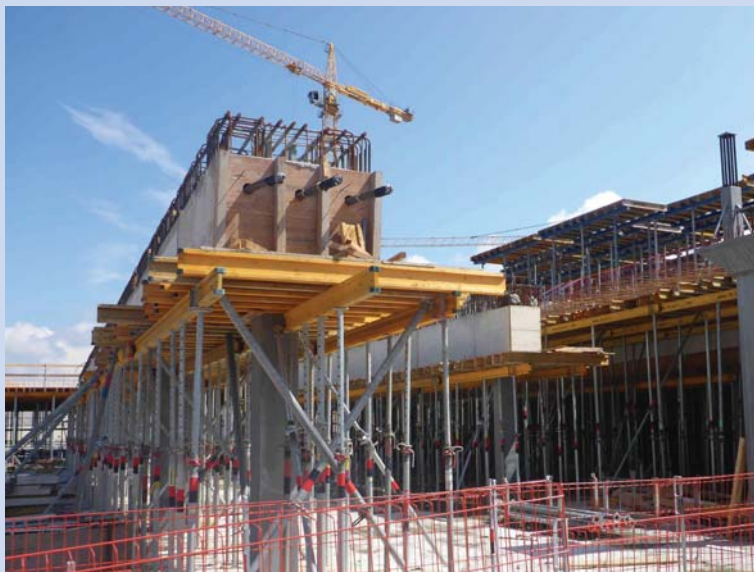
Unterzüge Einkaufszentrum: Kabel 1906
