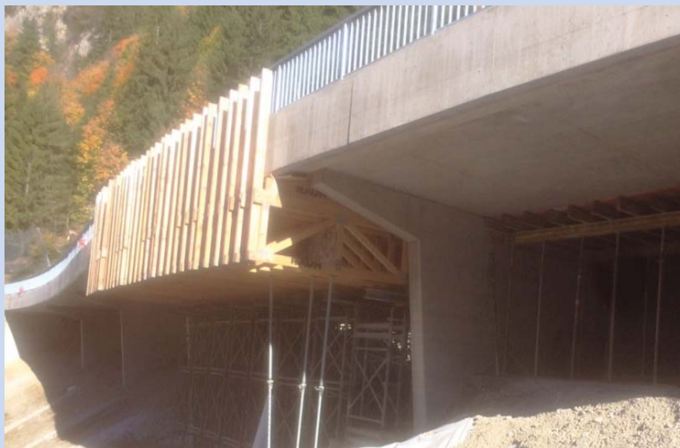
Pont lors du décoffrage
