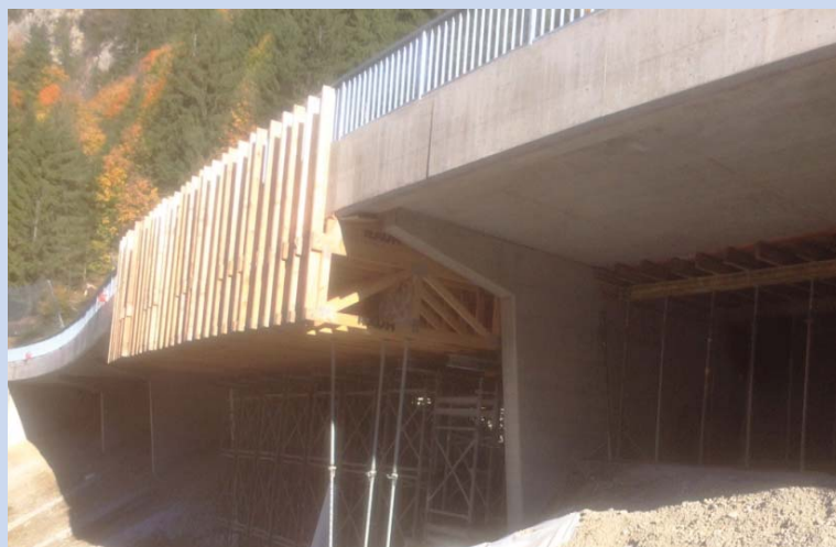
Brücke beim Ausschalen
