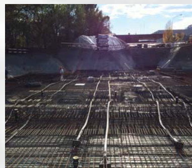
Vorspannung Bodenplatte
