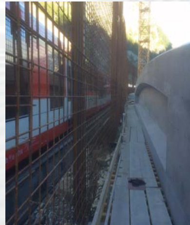
Ancien pont encore en service
