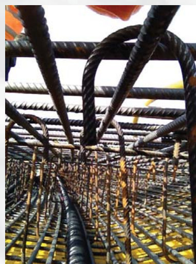
cavo nel ferro d'armatura
