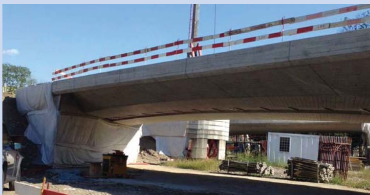
Ponte dopo lo scasseramento
