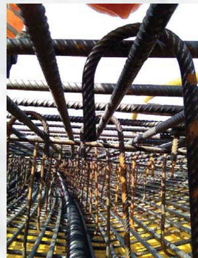
Spannkabel in der Armierung
