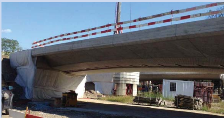
Brücke nach dem Ausschalen
