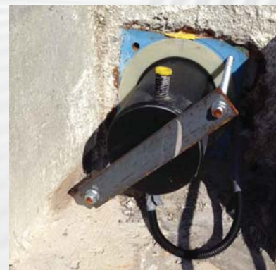
Verankerung mit elektrischer Isolierung
