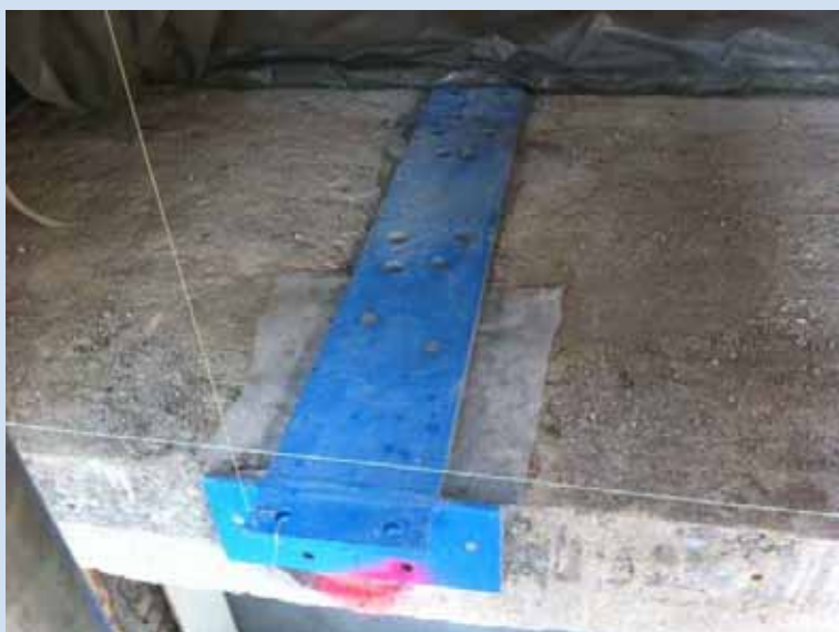
Lamelle eingemessen und nivelliert
