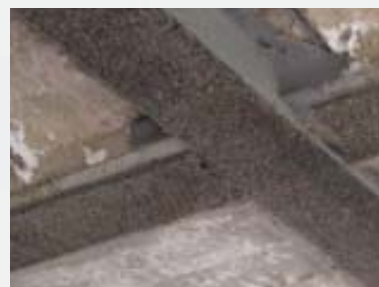
Abgesandete CFK-Lamellen
