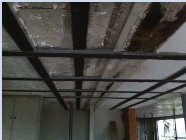
Zweilagige Verstärkung in den Geschossen
