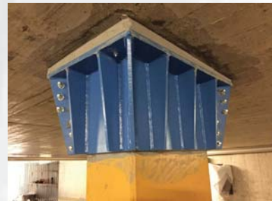
Verklebte Stützenkopfverstärkung
