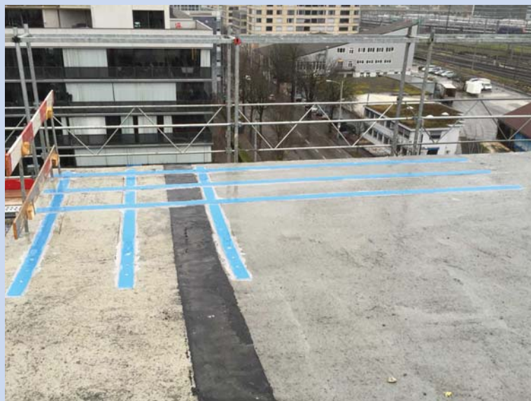
Lamellen als Verstärkung der oberen Armierung
