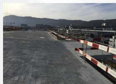
Nach Aufbringen der Bitumenabdichtung
