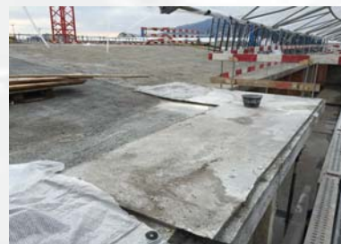
Verstärkungen mit Schutzmortel überzogen
