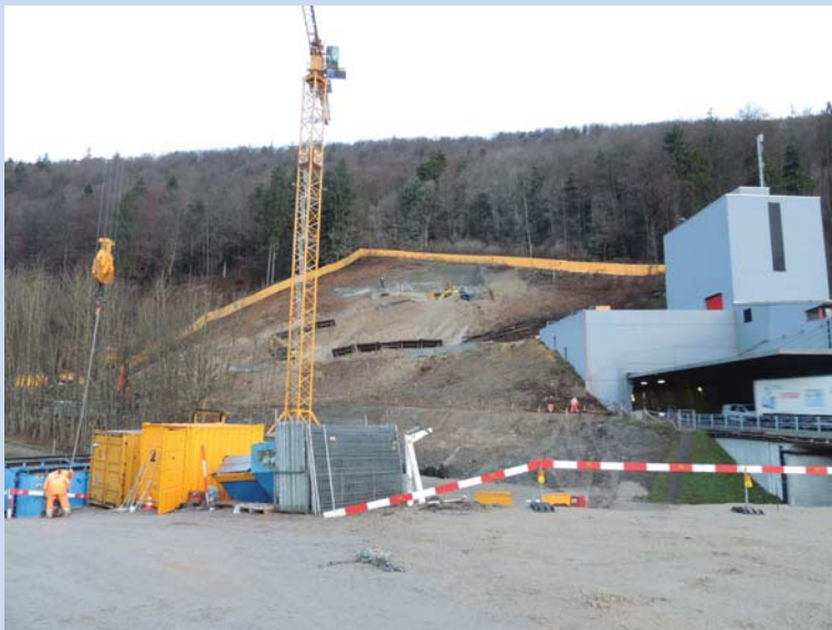
Baustelle bei Beginn der Bauarbeiten
