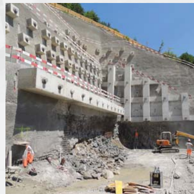
Portalwand im Bau
