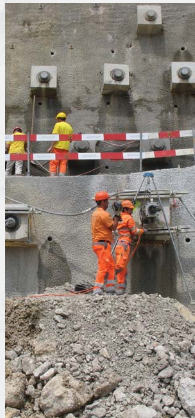
Spannarbeiten an einem Anker
