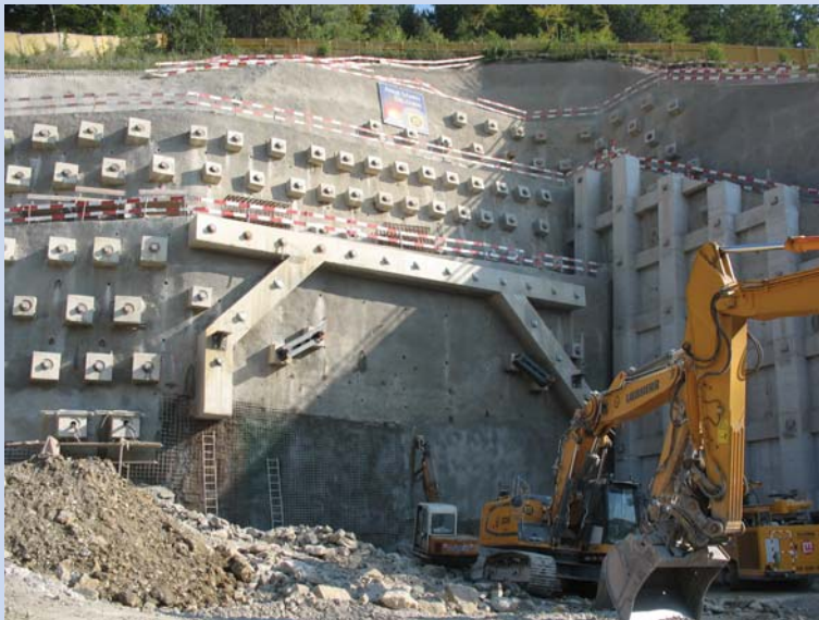
Südportal vor Installation der Tunnelbohrmaschine
