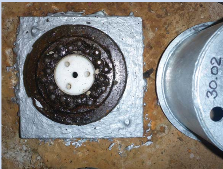
Beispiel: Anker nach Kontrolle
