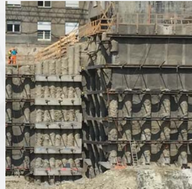
Anker zur Sicherung der Baugrube
