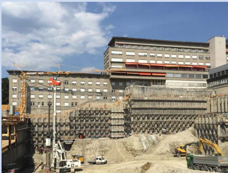
Baugrube mit permanenten und temporären Ankern
