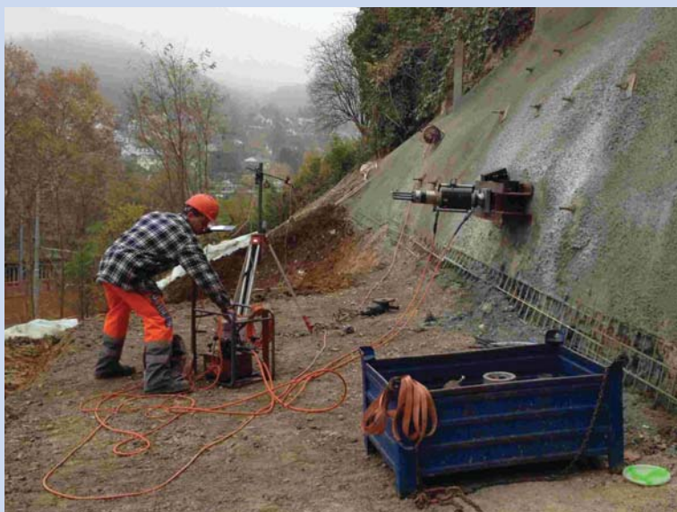
Beginn der Baustelle mit dem ersten permanenten Anker über dem Portal
