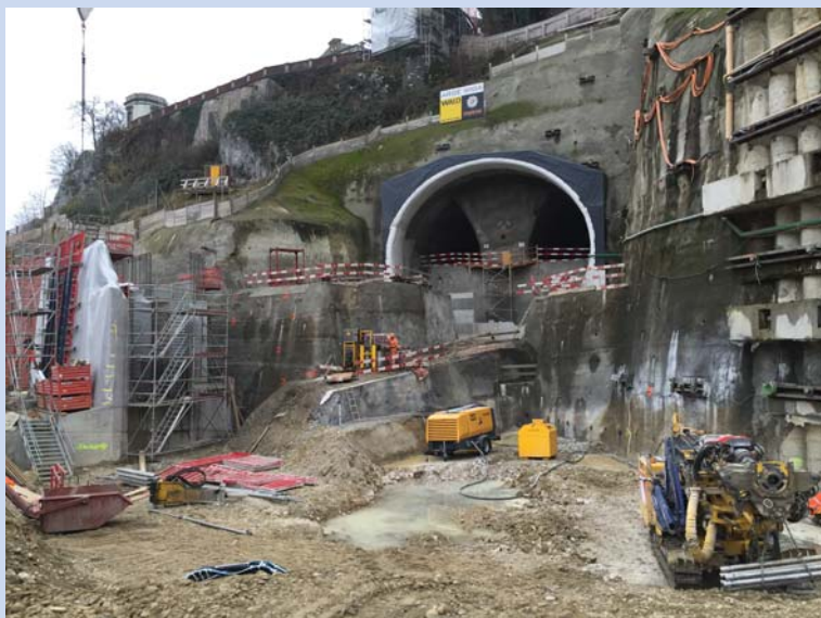
Blick auf das Südportal
