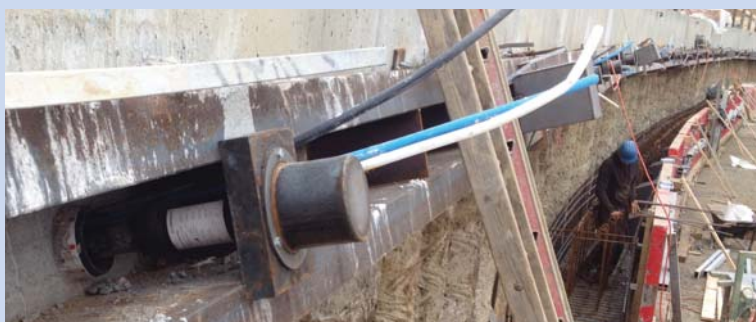
Permanente Anker in der Pfahlwand Bahndamm
