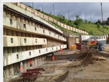
Sicht auf das Ende der Pfahlwand Bahndamm
