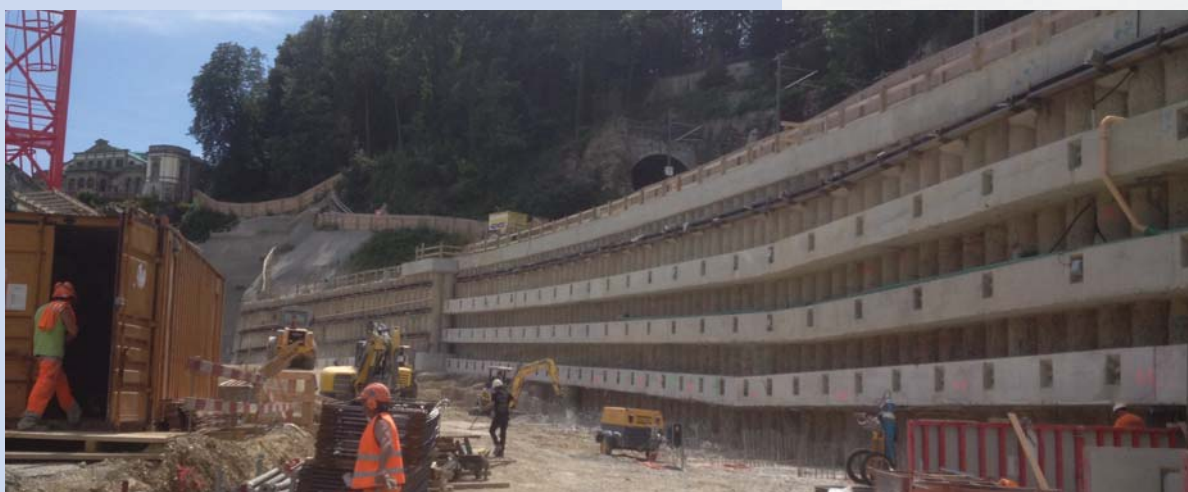
Bohrpfahlwand Bahndamm DB
