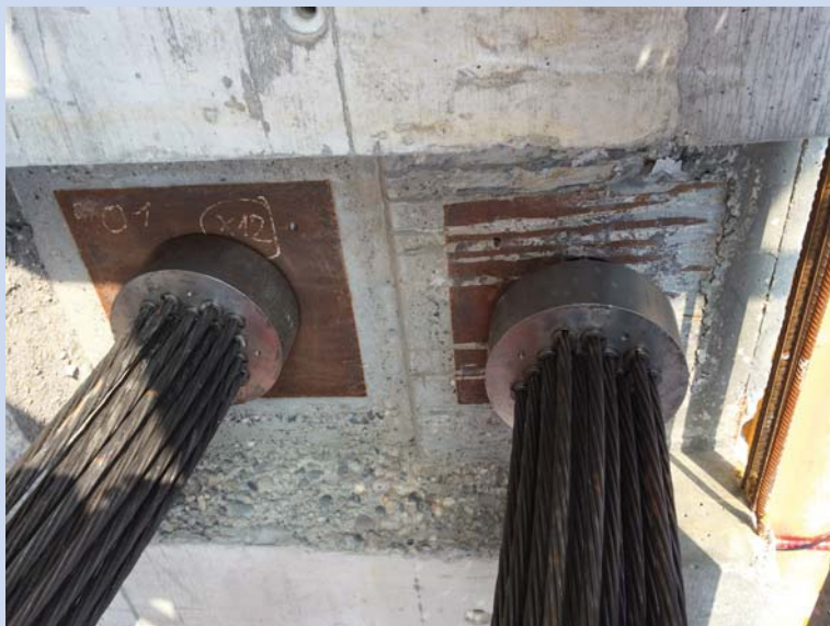
Litzenbündel mit Ankerkopf in ungespanntem Zustand
