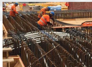
Hochpunktentlüftungen Längskabel
