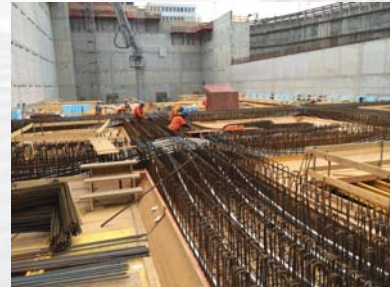
Längskabel werden beim Hochpunkt über die Querkabel geführt
