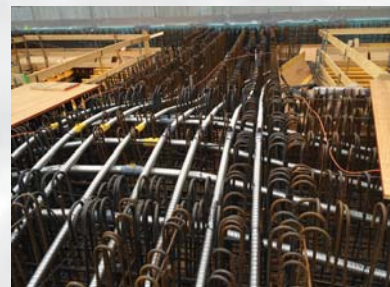
Kreuzungspunkt Längs- mit Quervorspannung
