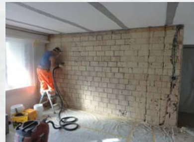
Vorbereiten einer Wand für CFK-Schnüre
