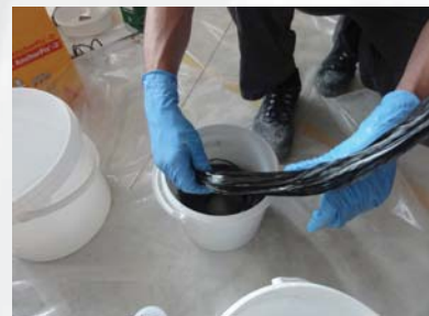
Laminieren einer CFK-Schnur vor dem Einbau
