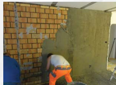
Fertigstellen des G-Grid
