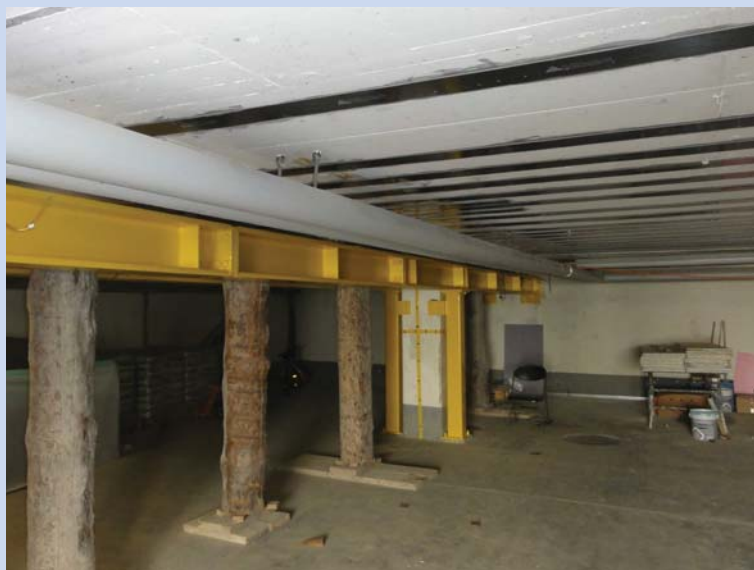
Decke mit geklebten CFK-Lamellen
