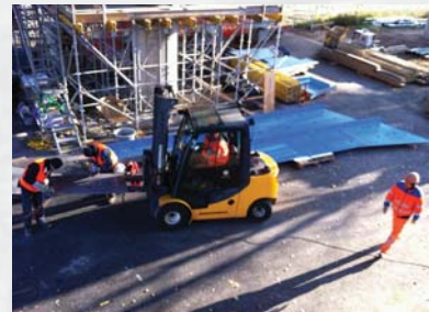
Werkplatz für Schweissarbeiten
