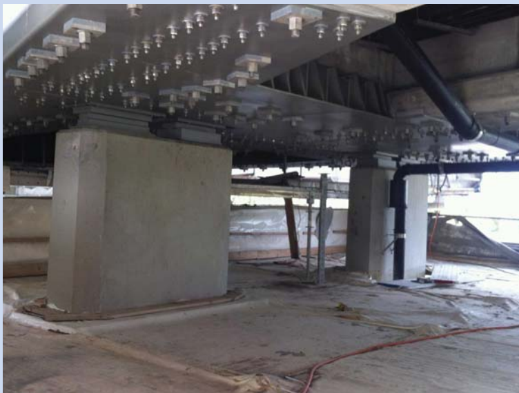
Endzustand fertig verankert
