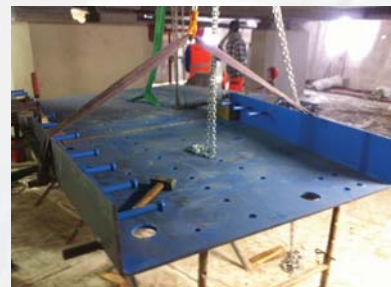
Einer der vor Ort geschweissten Kästen
