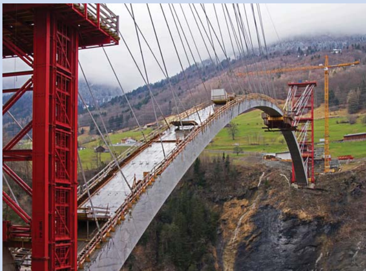
Brückenbogen im Bau
