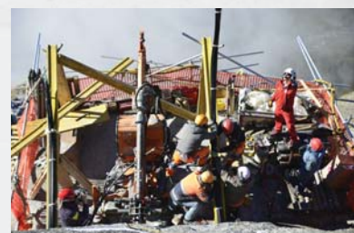
Einbau eines Ankers
