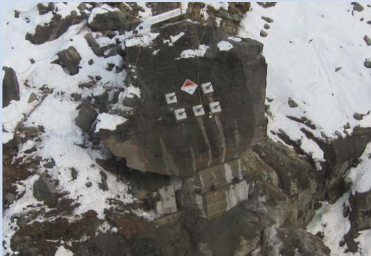
Situation nach Abschluss der Arbeiten
