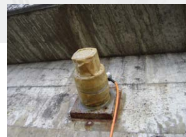
L'Avenal, Develier, nouvelle cellule
