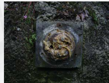
Tête d'ancrage, Crat d'Hermont, Porrentruy
