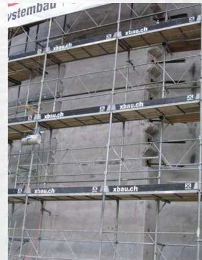
Ansicht nach dem Einstossen
