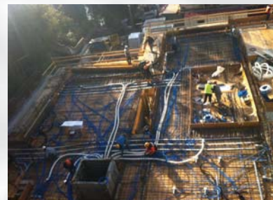
Vorbereitung der Decke
