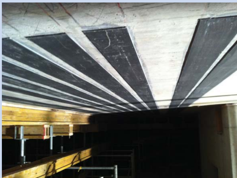
Decke verstärkt mit CFK-Lamellen
