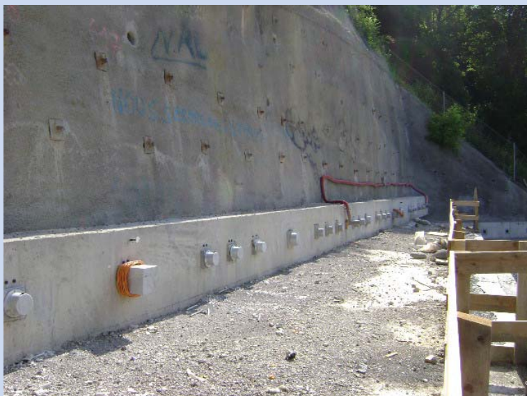
1er longrine sup. terminée
