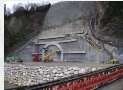
Vue d'ensemble du portail Sud
